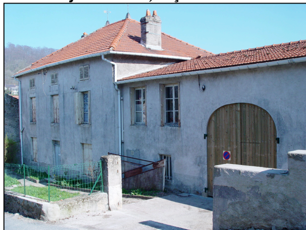
9 : Presbytère 19 ème , façade avant
